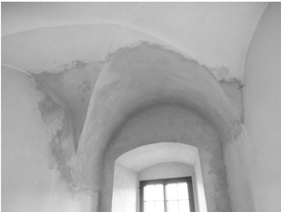
Fot.3. Prace naprawcze o w obrębie ścian zakrystii
